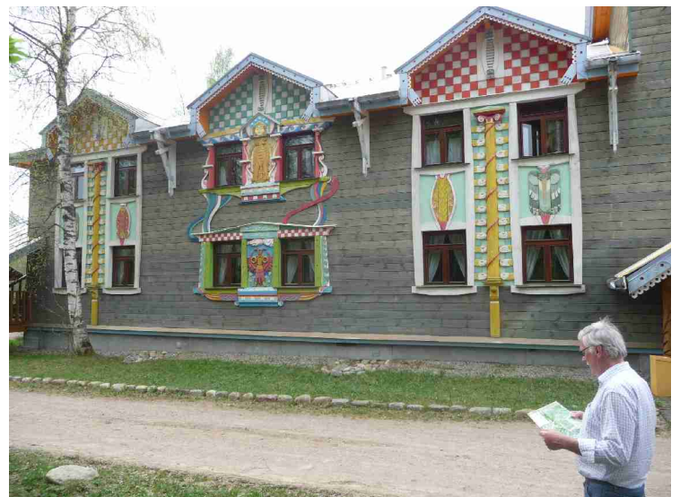
Det er lagt ned mye arbeid i utskjæringene.
