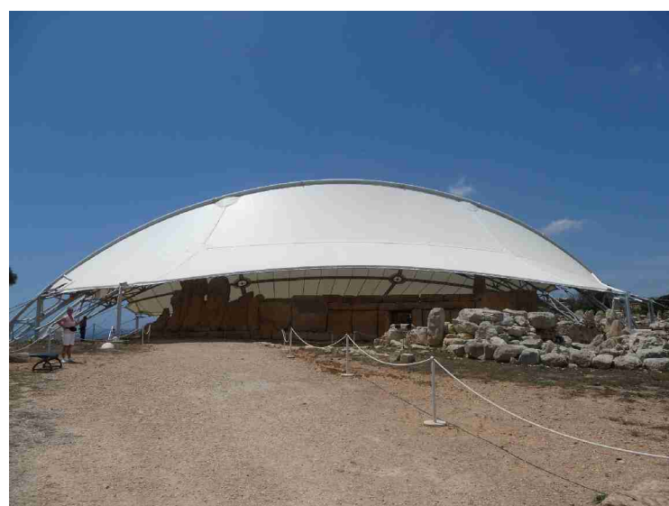
På grunn av erosjonen av steinene, er det blitt satt opp et telt som skal beskytte mot vær og vind. Det var ferdig i 2009.
