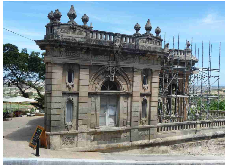
Et gammelt herskaps hus som det gjøres vedlikehold på.
