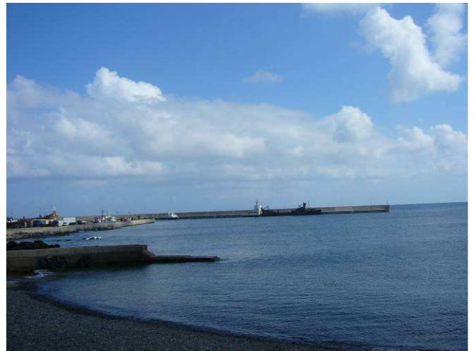
Litt av havnen. Den var Madeiras viktigste hvalfangsthamn. Hvalfangsten opphørte i 1981.
