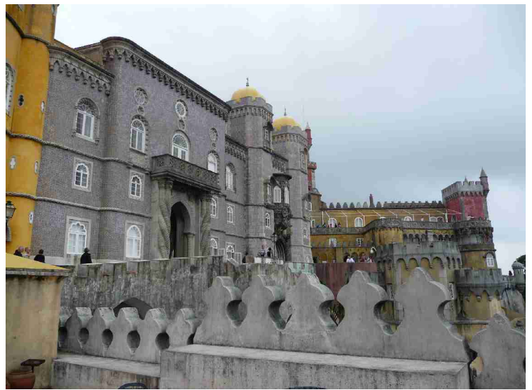
Den grå seksjonen inneholder den største hallen, ambassadørhallen, som ble brukt for mottakelser. Fronten er dekket av keramikkfliser.
