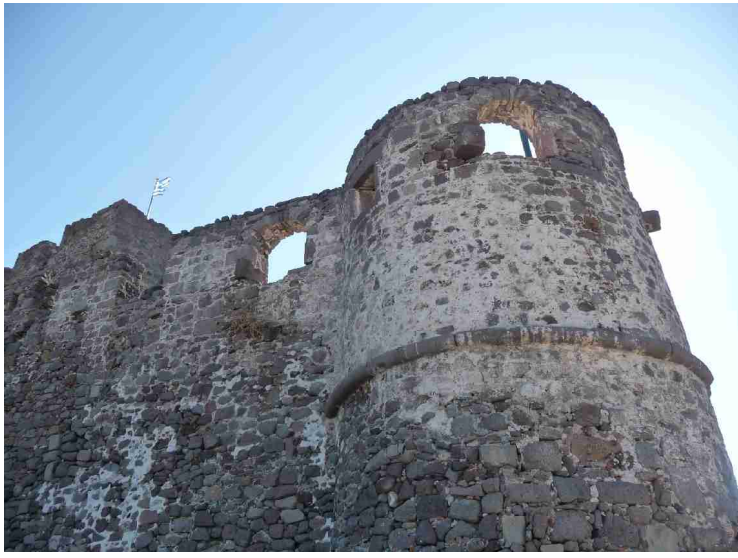
Noe av murene sett utenfra.
