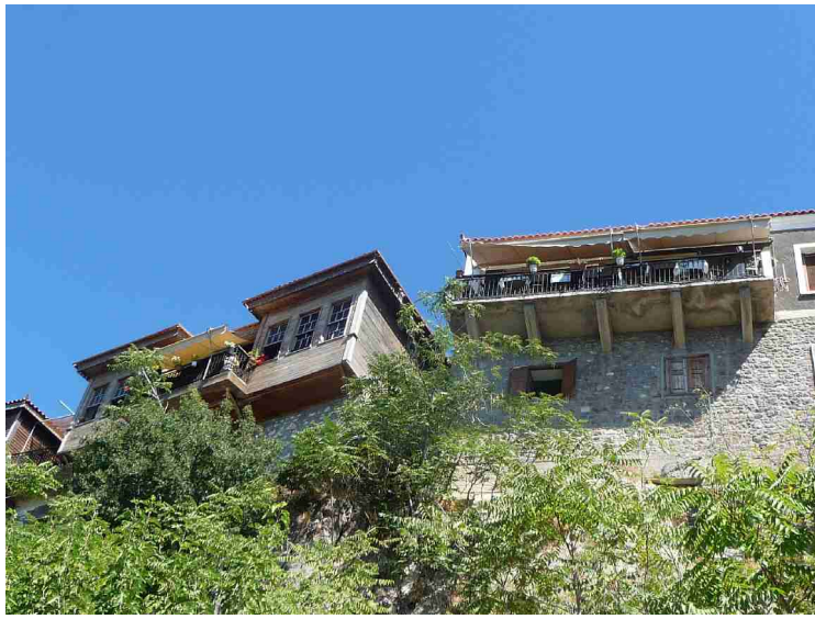
I dag tar vi enda et bilde av terrassene som henger ut over murkanten.
