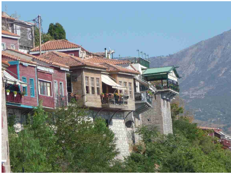
Enda et bilde av husene som er bygget utover kanten på muren.
