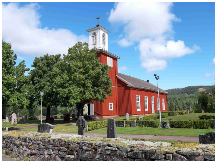
Dette er Lekvattnet kirke som ble bygget i årene 1850-53.
