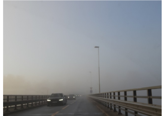
Over brua i Vormsund.
