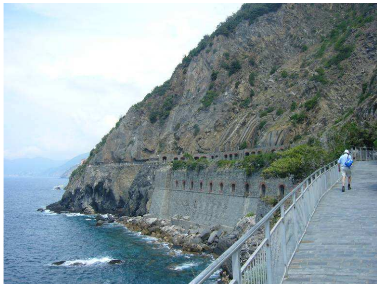
Stien er delvis hogget ut i berget og støttet opp med betong
