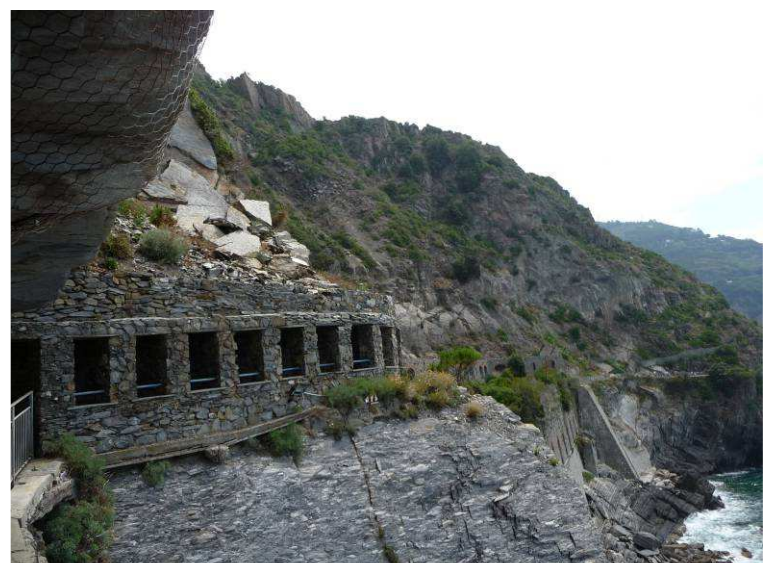
Stien er delvis hogget ut i berget og støttet opp med betong
