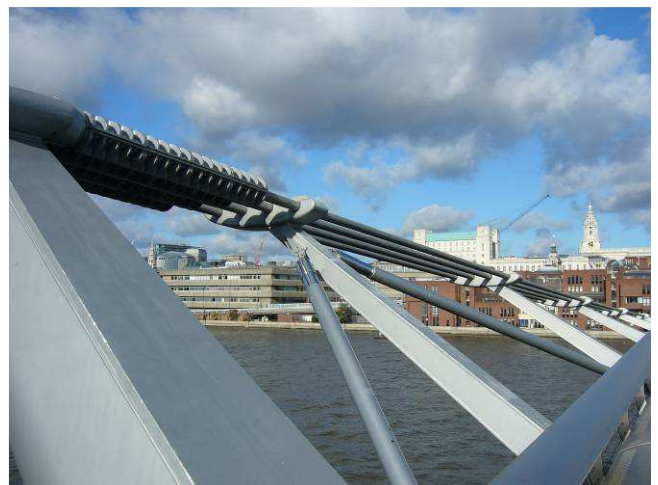
Her er det skikkelige fagverkskonstruksjoner, omtrent som på plogene fra Kverneland.
