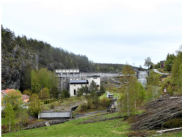
Vi ser Brekke sluser til høyre. De var ferdige i 1852. Engebret Soot ledet byggingen. Det er fire slusekammer og løftehøyden er 26.6 meter.
