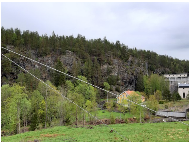
Her ser vi demningen til høyre. Brekke kraftstasjon ble gjort ferdig i 1924. En større oppgradering av stasjonen skal være ferdig i 1922.
