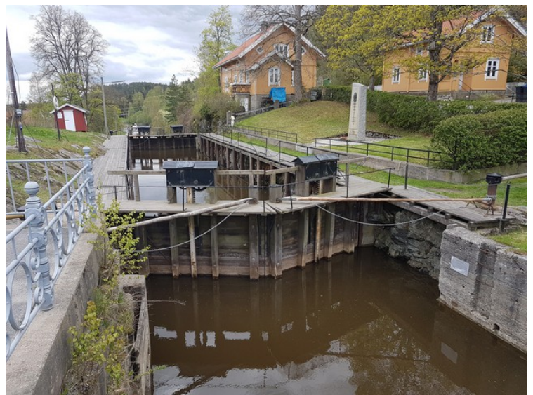
Dette er det øverste slusekammeret. Det er tre slusekammer i slusene her.
