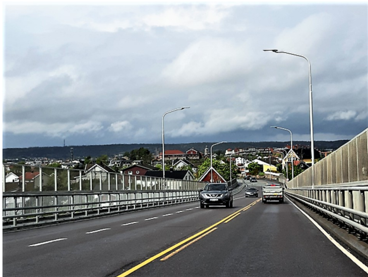
Fra toppen av brua ser vi mot Fredrikstad.
