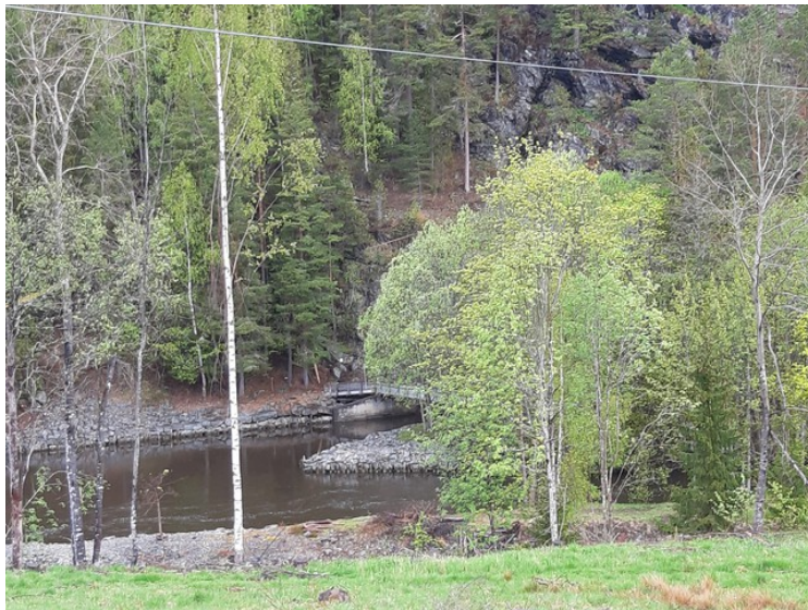
Her ser vi en gangbrua over det ene løpet i Stenselva nedenfor demningen og slusene.
