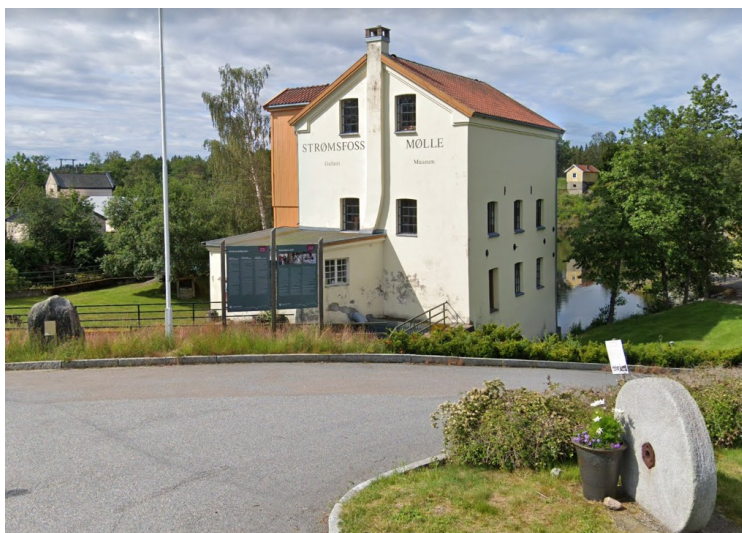
Ved fossen ligger Strømsfoss Mølle . Det er kraftstasjon i underetasjen.
