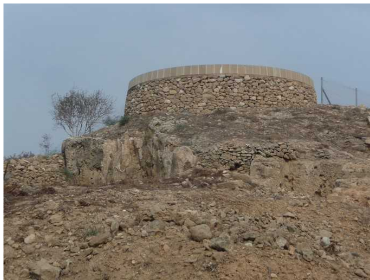
Denne konstruksjonen ser forholdsvis ny ut.
