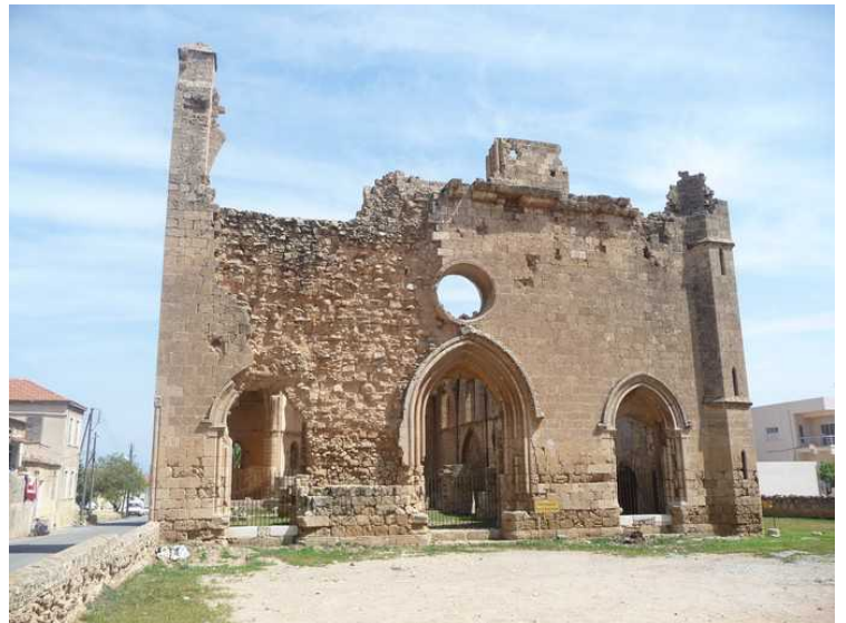
Sett fra vestsiden.
