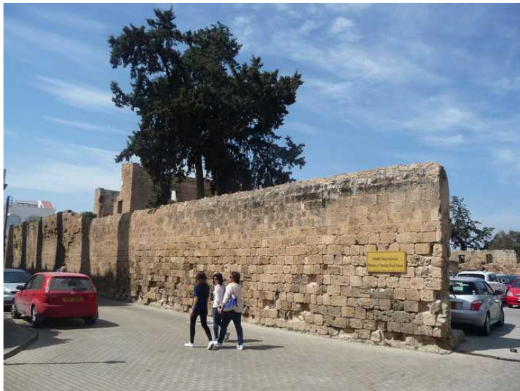
Litt av muren rundt det venetianske palasset. Det er et område på innsiden som brukes som parkeringsplass.
