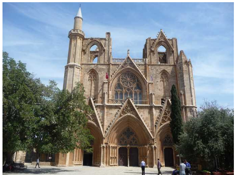
Det er tre innganger på vestsiden.
