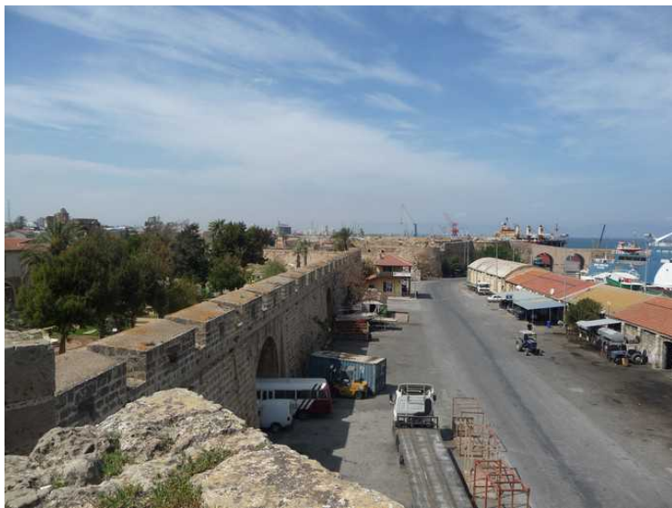
Her står vi på Othellos Tårn og ser nordover på utsiden av muren.
