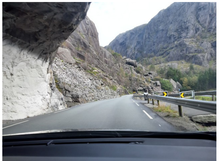
Ute av tunnelen.
