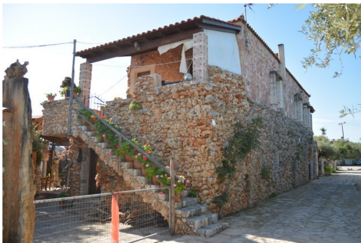
Trappeoppgang av murt stein.
