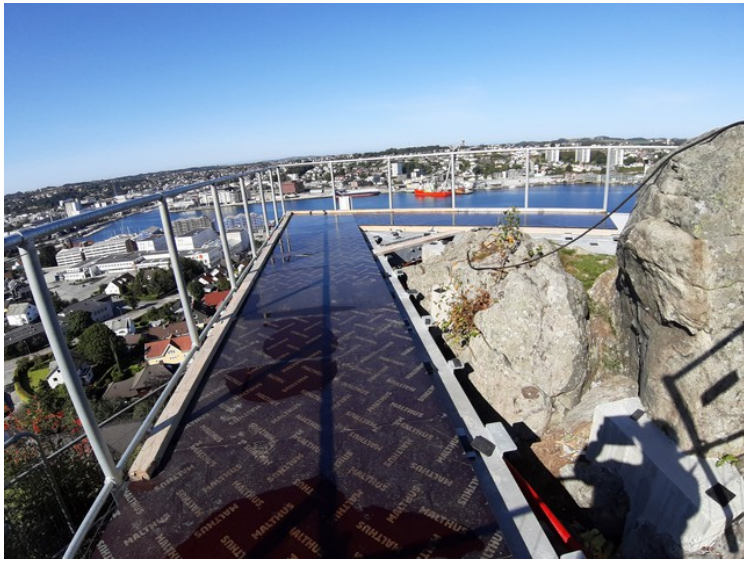
Dette er plattformen som er under bygging.
