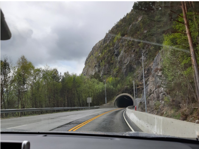
Her kommer vi til Botshei tunnelen. Den er bare 200 m lang
