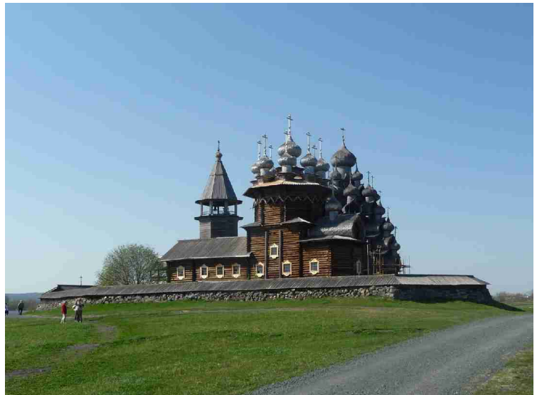
Det mest spesielle med disse bygningene er at de ble satt opp uten en eneste spiker eller metallbjelke.
