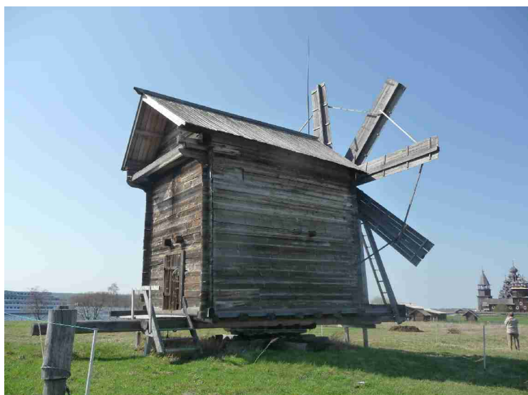
Vinddrevet kornmølle. Den står på en dreibar sokkel, så det var mulig å stille den i vindretningen.
