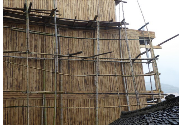
Dagen etterpå ser vi hvordan bambus blir brukt til stillasbygging.
