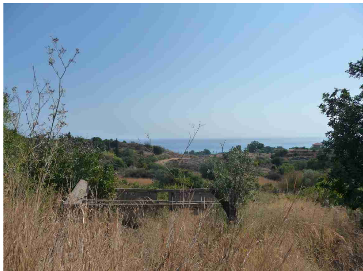
Dette huset ble sikker ødelagt under skjelvet.
