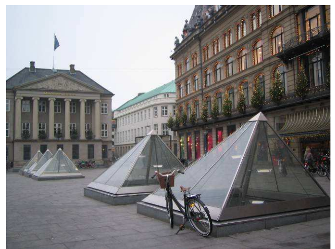
Under her ligger en av Metrostasjonene og dette er takvinduer for denne. Ganske originalt.
