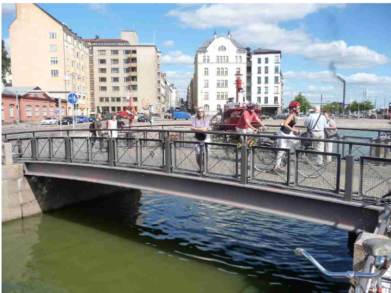
Gangbro over kanalen.
