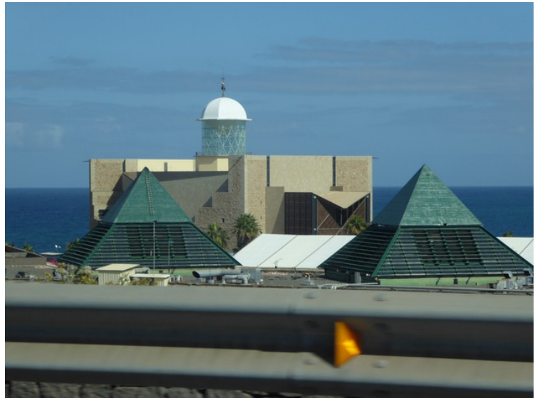
Bygningen med det hvite tårnet er Auditorio Alfredo Kraus , som er en konsertsal. Pyramidene er ventilasjonstårn på et stort kjøpesenter.
