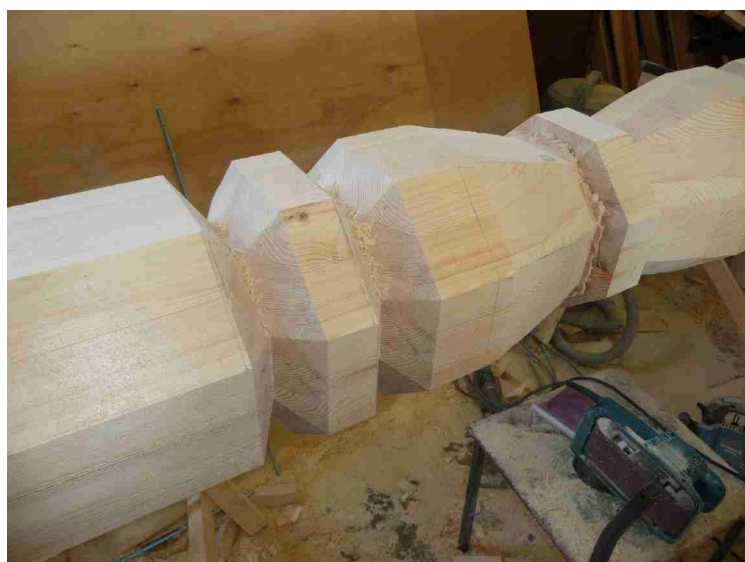
De har begynt på bearbeidingen av stolpen.
