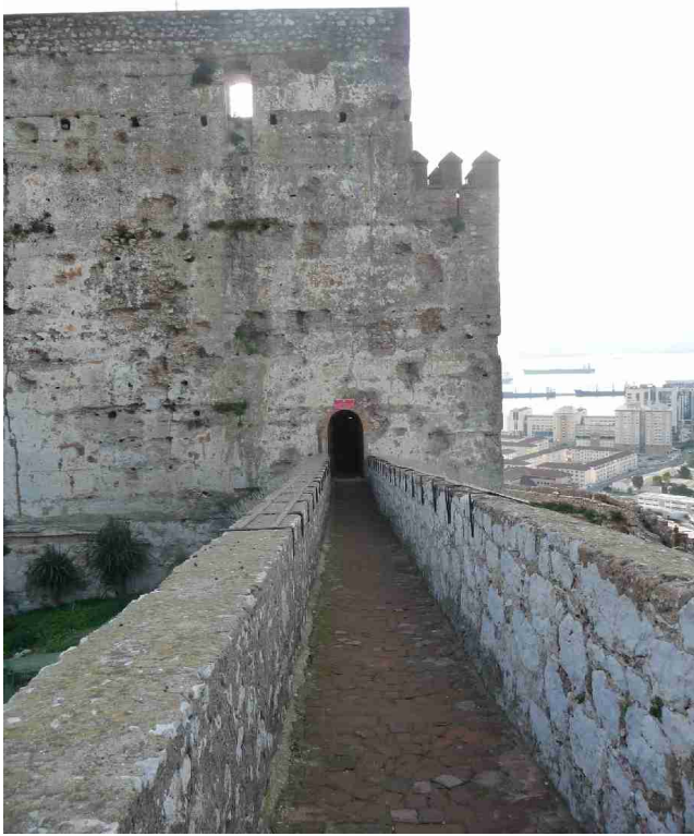
Vei på muren inn til tårnet.
