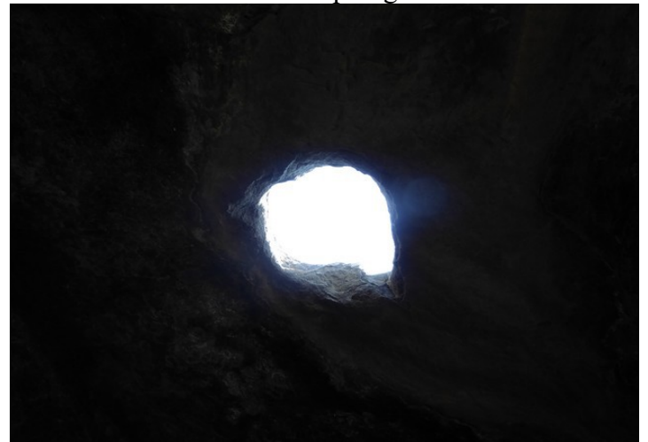
Regnet kommer inn gjennom dette hullet i taket.
