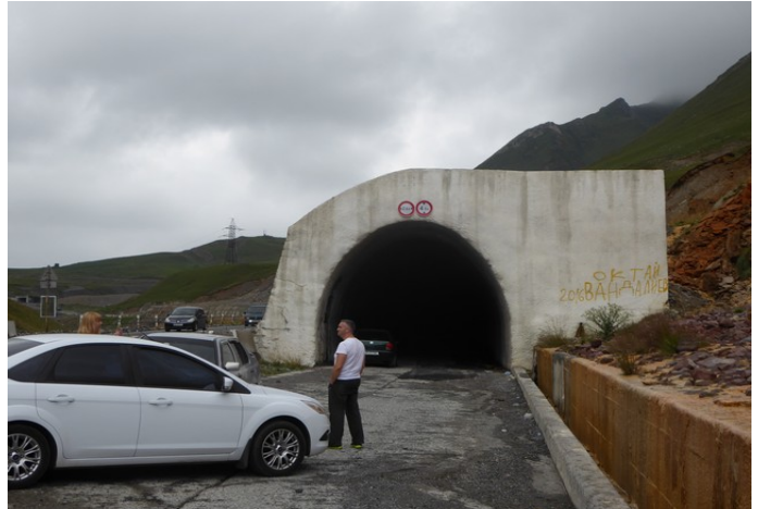
Dette er en betongtunnel som er laget langs veien, slik at det skal være mulig å kjøre når snøfonnene fremdeles ligger her.
