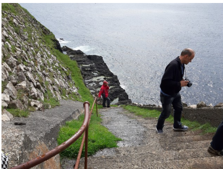
Her går trappen nedover. Det står skilt på toppen at det er forbudt å gå i trappen, men det var mange som ikke brydde seg om det. Rekkverket var rustent og ødelagt.
