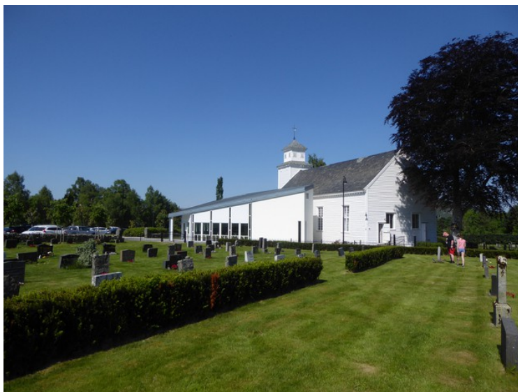
Nå har den fått et tilbygg. Noen synes det er fint mens andre synes det er fælt.
