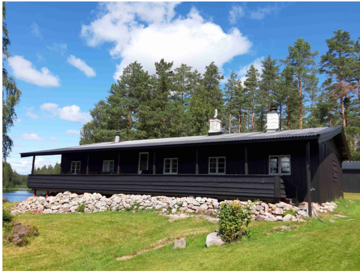
Koia sett fra nedsiden.
