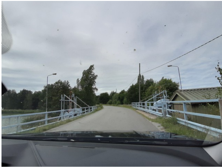
Dette er Simonbyslussen. Slusen ble bygget på 1960-tallet. Den skiller sjøvann og ferskvann inne i fjorden på øya. Det kan gå småbåter gjennom slusen. Den inspiseres vår, sommer og høst.
