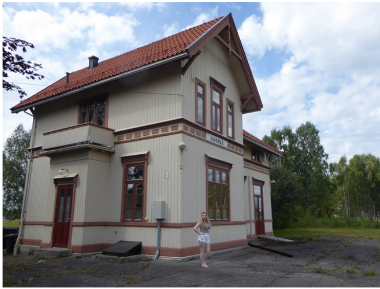
Stasjonsbygningen på Namnå. Det er bare godstog som går på banen i dag. Persontrafikken var slutt i 1994.
