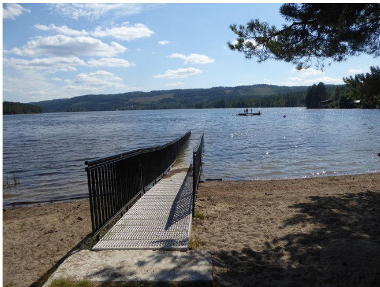
Nå er det laget en rampe slik at man kan kjøre med rullestol helt ut i vannet.
