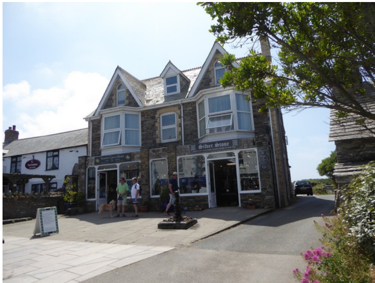
Ved siden av posthuset ligger det butikker og restauranter.
