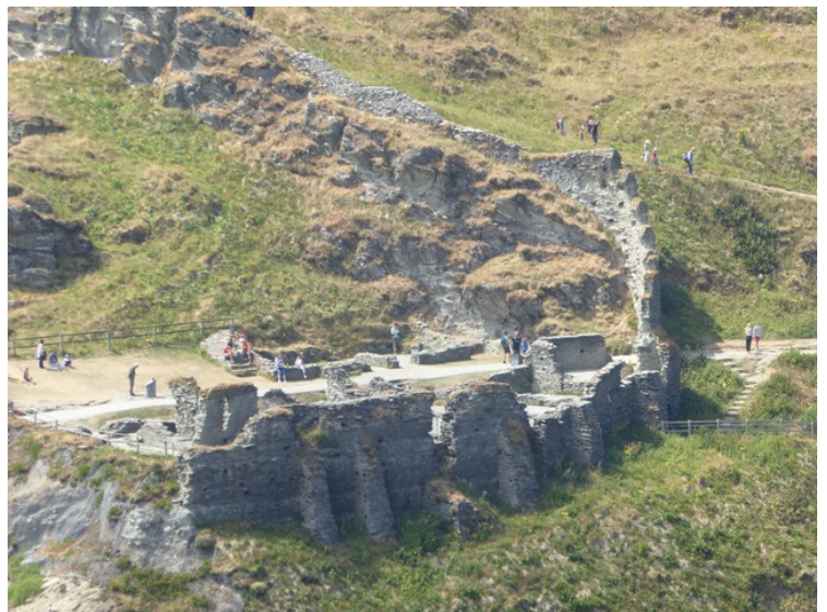
Ruiner av porthuset med gårdsrom på øya.
