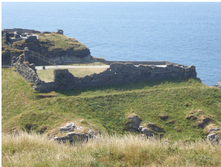
Dette er ruinene av porthuset og gårdsrommet.
