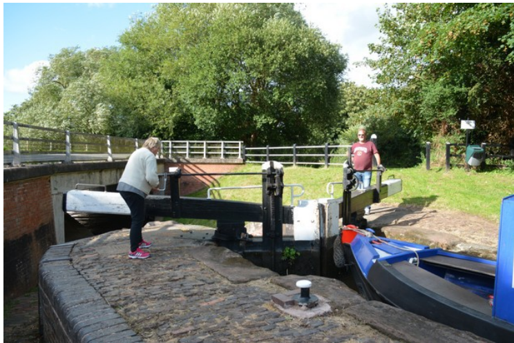
Her åpner Anni og Eldor sluseventilene på hver sin side for å slippe vannet ut av slusa.
