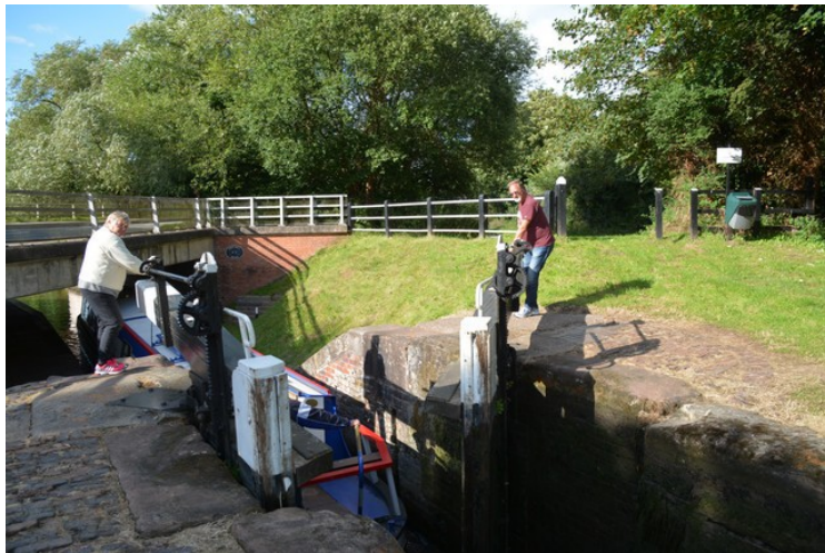
Vannet er ute og de kan åpne sluseportene på hver sin side.
