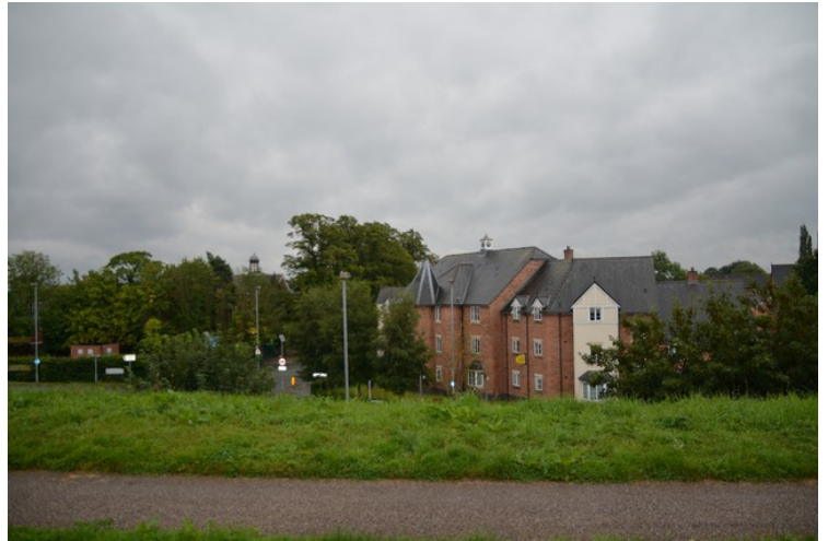
Her er kanalen bygget opp over landet ellers.
