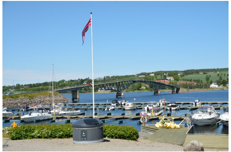
Her er vi kommet over på Helgøya. Vi er på Sund og ser tilbake mot Nessundet bru og fastlandet. Brua ble åpnet i 1957.
