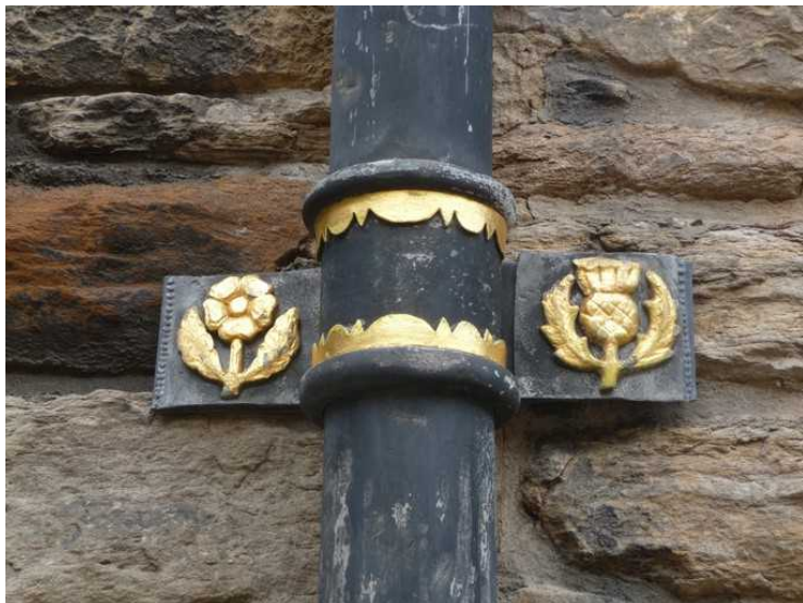
Før vi går inn i Great Hall , må vi bare ha bilde av festene for dreneringsrørene fra vannrennene.
