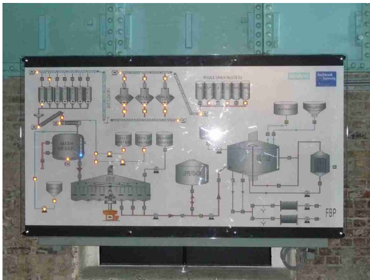
Diagram over produksjonsprosessen
