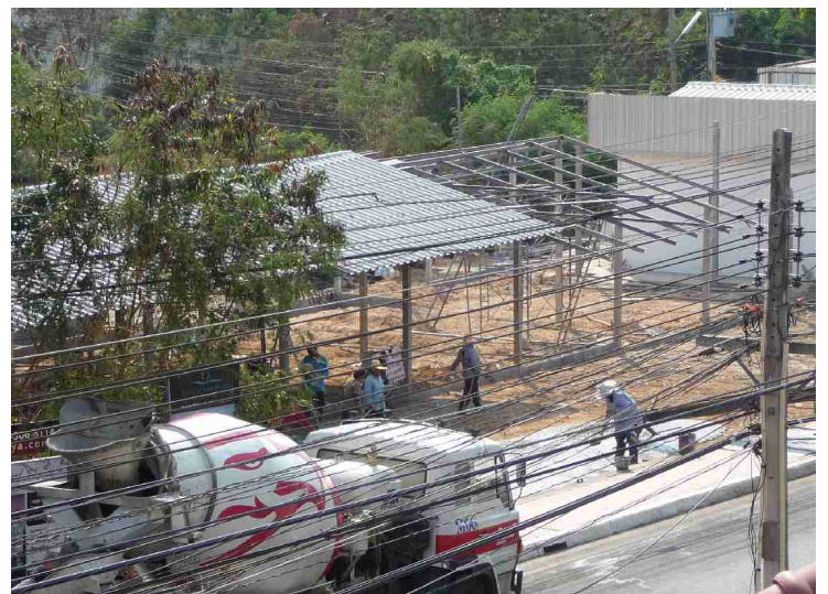
Her kommer ferdigbetongen. Betongen legges rett på bakken.
