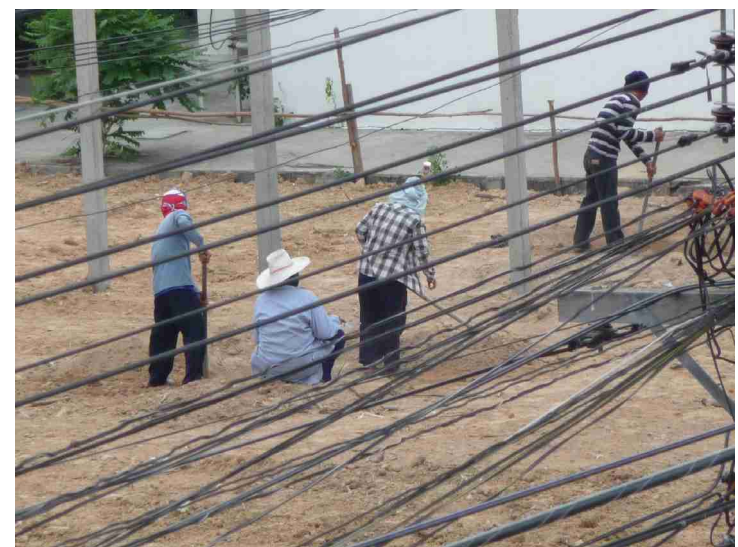
Deretter jevnes bakken.
