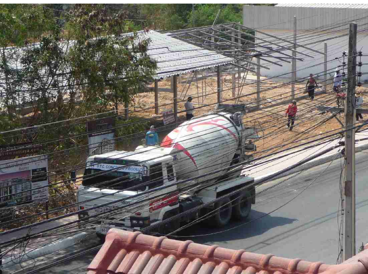
Her kommer ferdigbetongen. Betongen legges rett på bakken.
