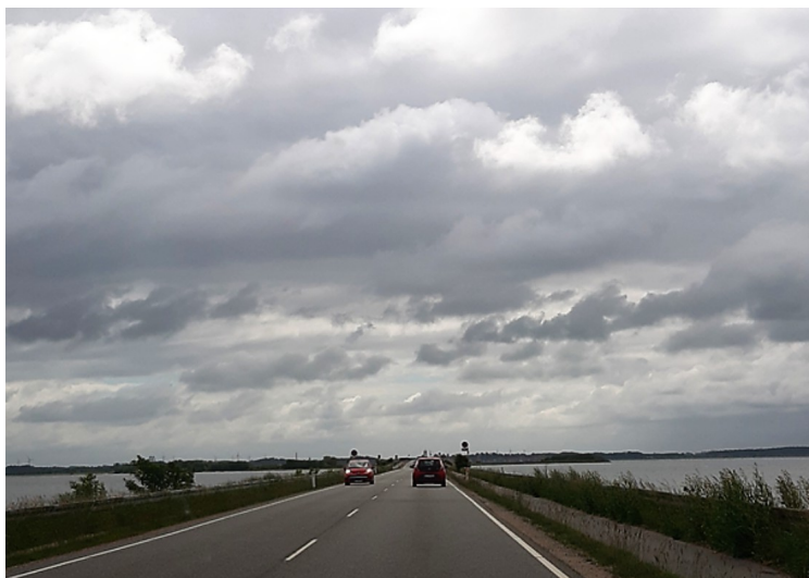
Veien videre mot Langeland går på fyllinger i sundet og på en lav bro.
