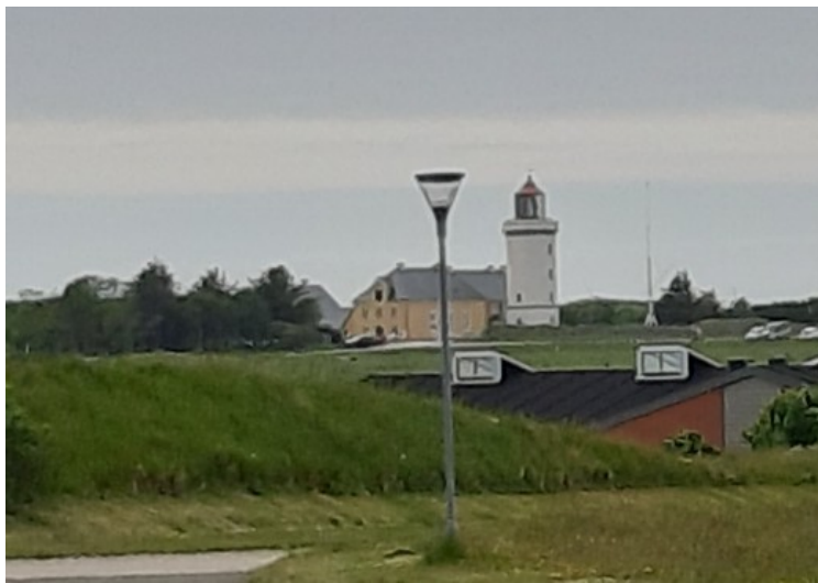
Hanstholm fyr var det første fyr på Jyllands vestkyst. Det ble bygget i 1843. Det ble fredet i 1979.
