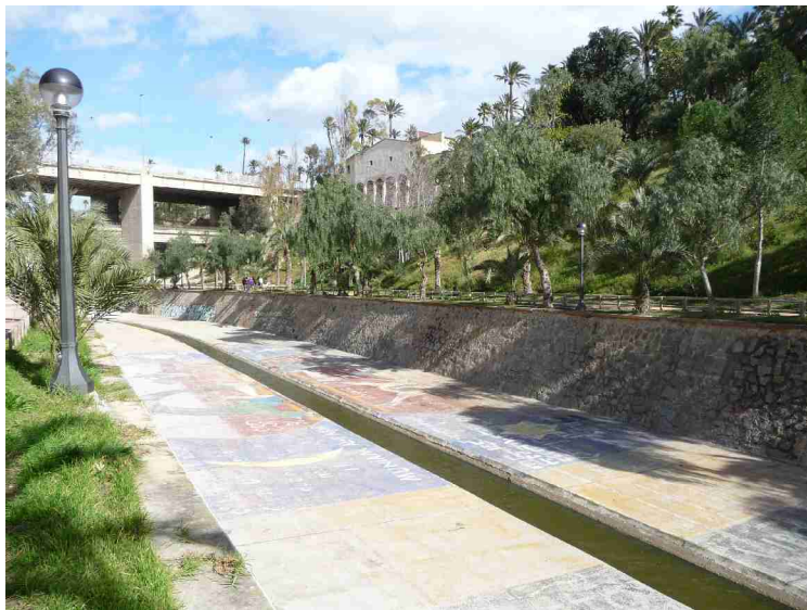
Vi parkerte rett ved siden av Rio Vinalopó. De har faktisk fundamentert elveløpet gjennom hele byen. Når det ikke regner så mye renner elva bare i den lille renna i midten.
