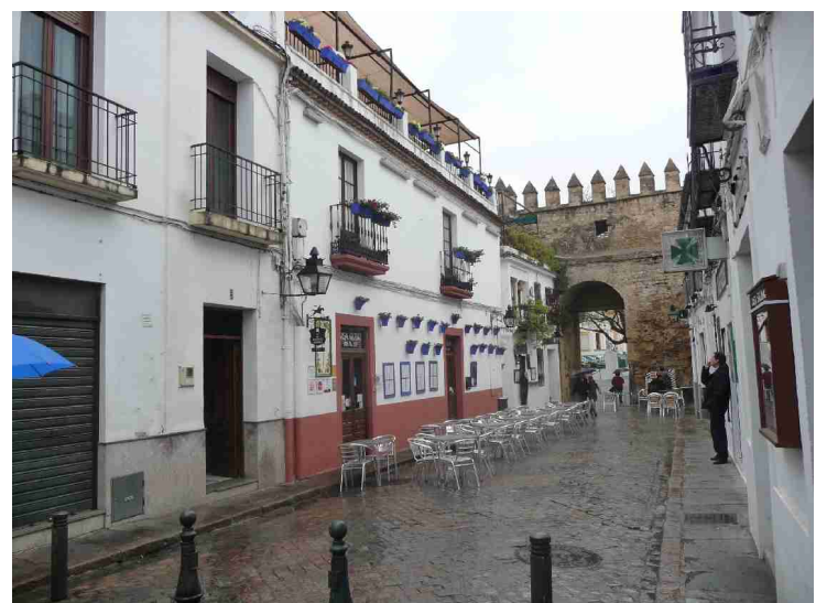
Vi kaster et blikk bort på den sydlige bymuren idet vi går forbi. Vi ser Almodovar-porten .
