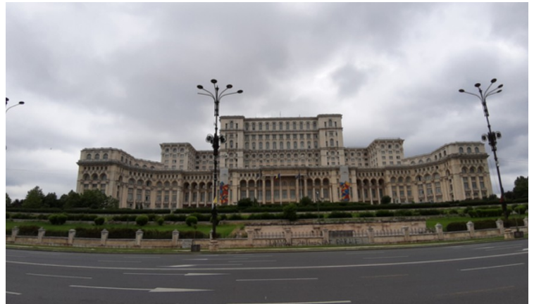
Vi måtte også se Parlamentsbygningen . Det er verdens nest største bygning etter Pentagon i USA.
