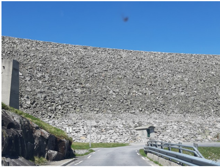
Dette er demningen i Rosskreppfjorden .
