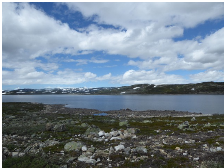
Her er vi ved innsjøen Ørteren . Sjøen er regulert for Ørteren kraftverk .
