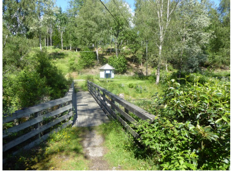
Dette er ved Svanfoss sluse . En gangbru går over kanalen.
