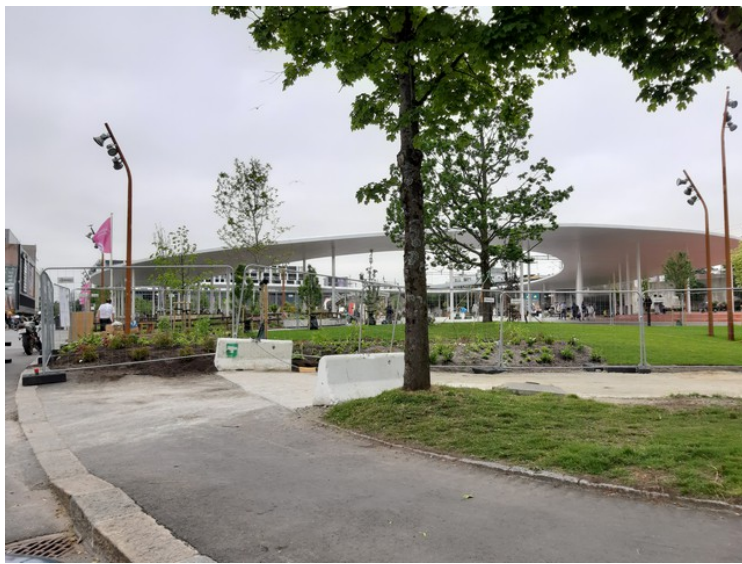
Rutebilstasjonen i Sandnes er oppgradert dette året. Det som viser best igjen er dette sirkelformede taket.
