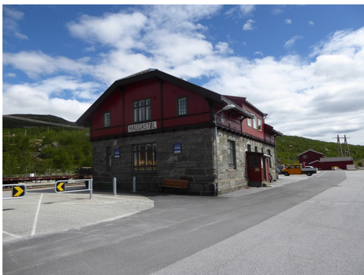
Stasjonsbygningen i Haugastøl.
