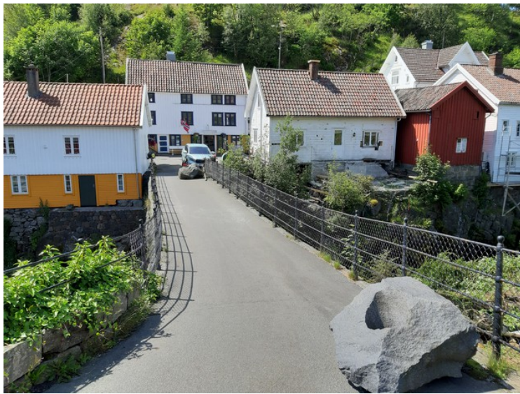
Brua er stengt for bilkjøring.
