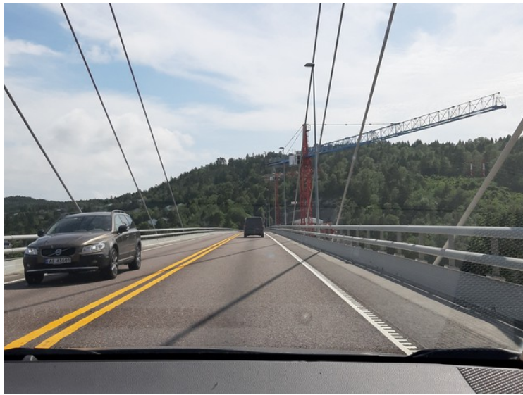
Så er vi på Grenlandsbrua som går over Freierfjorden mellom kommunene Porsgrunn og Bamble . Den ble åpnet i 1996.
