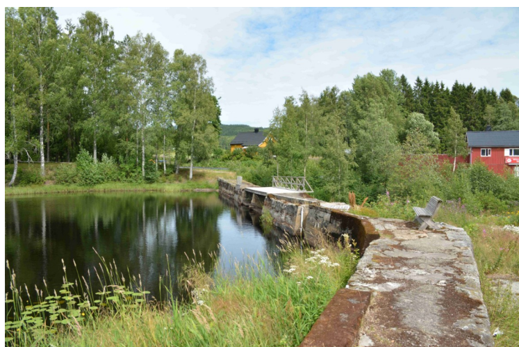
Dette er dammen. Den er ca 100 m lang med to damluker, to flomløp, bunnluke og fløterrenne. Den har blitt bra vedlikeholdt.
