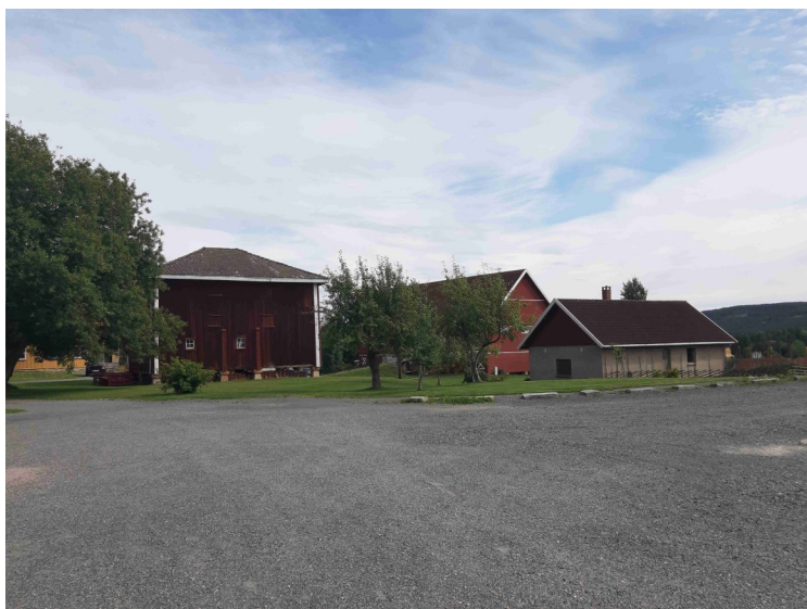
Flere bygninger sett fra parkeringsplassen.
