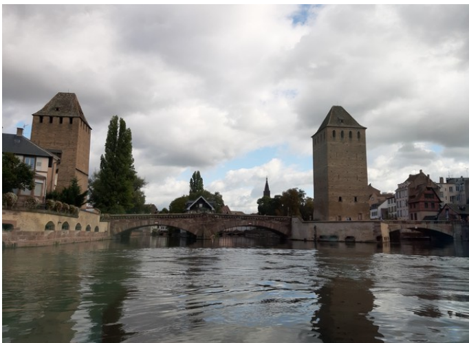
Two towers, Hans von Altheimturm and Heinrichturm Weith the bridges between.
