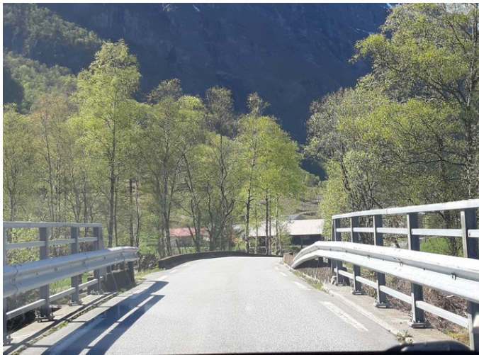
Bridge over Brådlandsåna.
